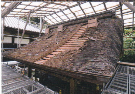
解体作業の様子
